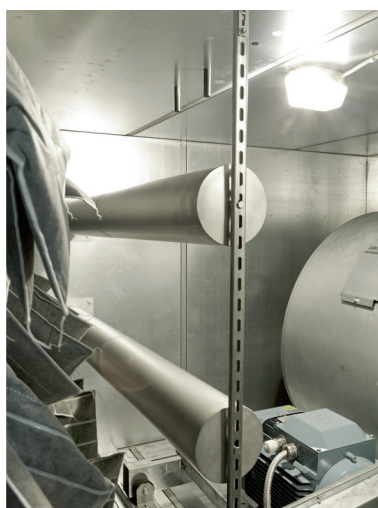
5. ábra: A füstgázok gőzpárástóból történő hozzákeverése a távozó levegőhöz a vízszintes elosztócsöveken keresztül történik. (Az összes ábra a Condairtól származik)
