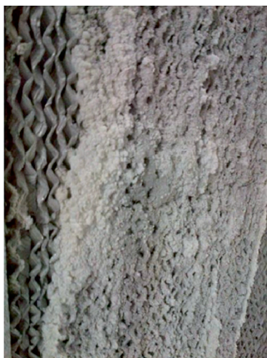
2. ábra: Az évek során a párasító lépcsjteken masszív lerakódások képződnek. Ezek káros hatással vannak a légpárásításra és a friss-levegőre, és a nagy nyomásvesztések miatt magasabb ventilátor-teljesítményt tesznek szükségessé a levegőszállításához.
